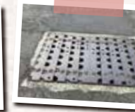
道路の側溝に使用されているアプト時代のラックレール。
